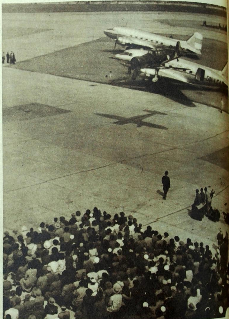
...kiittää pian hallintorakennuksen ensimmäisen kerroksen tasalta katsomon editse. (E. Viitasalo)
